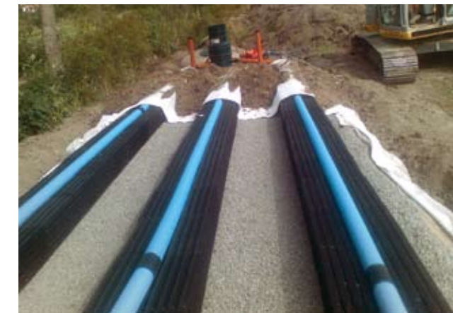
Medfølgende fiberduk 12 x 4 m legges ut over BioModulene og sprederrøret for å forhindre at grøften og BioModulene blir forurenset. Fiberduken legges over og på siden av BioModulene.
