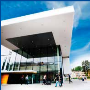
Akershus universitetssykehus (Ahus), Lørenskog
